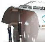
Cobertura do conjunto de recalque
